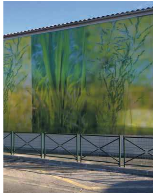
Colegio Santoni, La Garde, Francia Acristalamiento: Danpalon® Estampado de 16 mm Arquitecto: La Garde, Becker Sylvie
