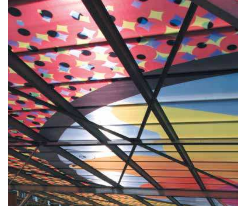
Escuela Secundaria P. Mendes, Arques, Francia Acristalamiento: Estampado Danpalon® Arquitecto: Soupey Toth Architect
